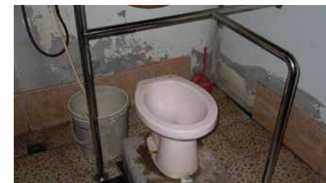
Carlos fik installeret et toilet i huset
